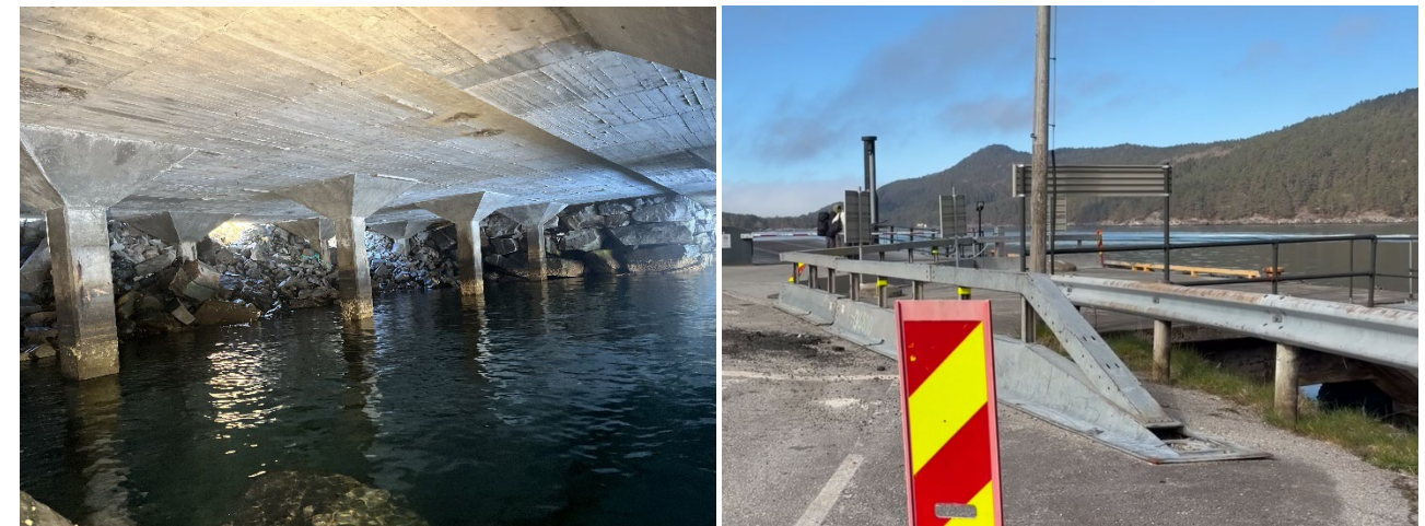
Figur 5-21 Venstre: Underside av kaiplate under kommunalt lagerbygg. Høgre: Avsperra kaikonstruksjon foran ferjebås. Kjelde: Vestland fylkeskommune og Multiconsult.
