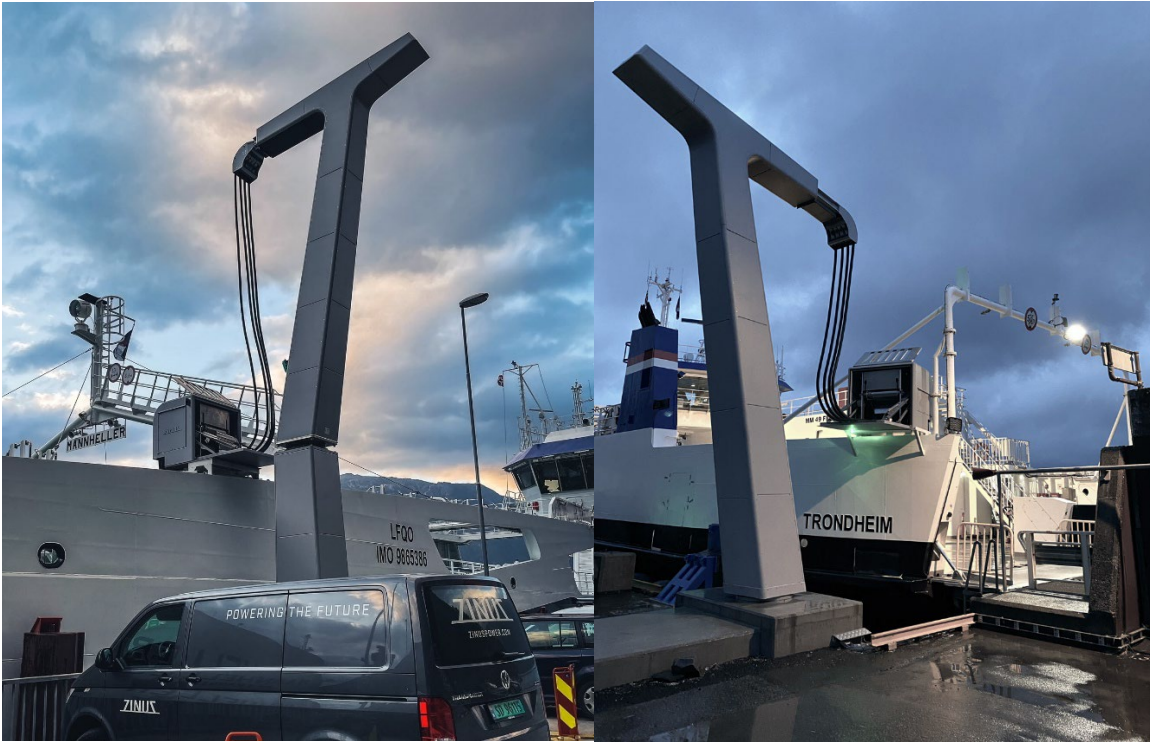
Figur 6-6 Zinus ladetårn i bruk på to andre samband i Noreg. Kjelde. Zinus Power.
