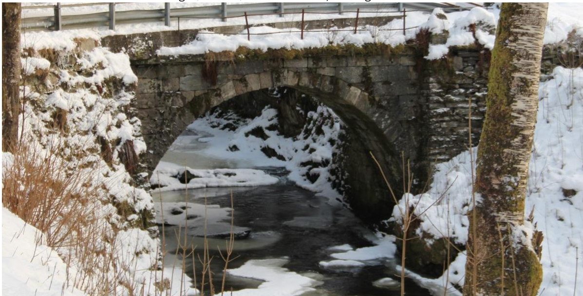
NR. 36 Salbu bru, einaste kvelvingsbrua i Hyllestad, bygd i 1908. Foto: Oddhild D. Engedal.
